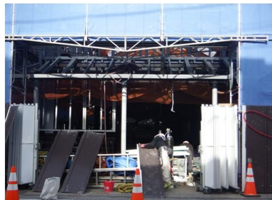
【高岡信用金庫】修理
