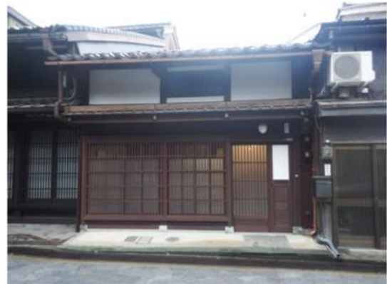
【金森家主屋】修理後
