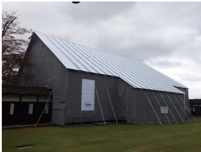
【大庫裏】仮設設置
