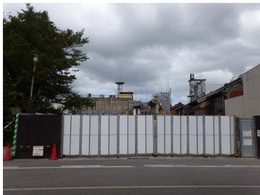
【高岡信用金庫】修理前
