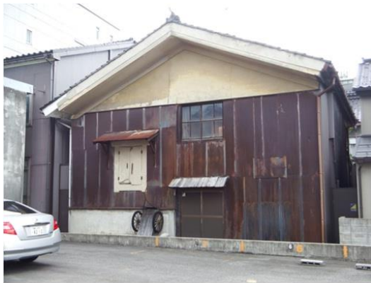
【若森家土蔵】修理
