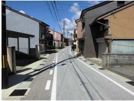
施工後(南側から)
