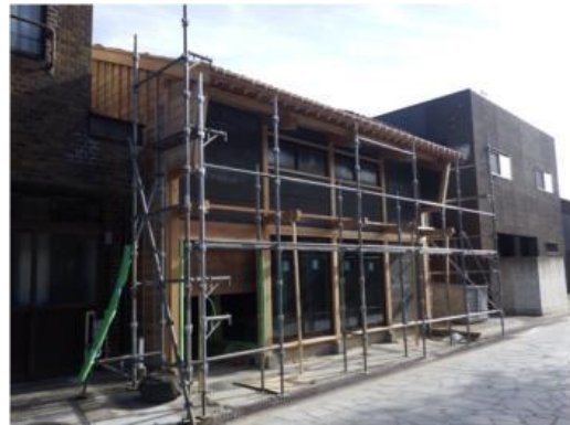
【竹中家主屋】修景工事中
