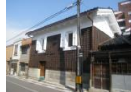
金森家住宅土葺修理後
