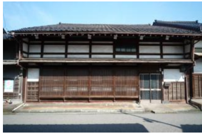
【平成26年度事例】 歴史的風致形成建造物「有藤家住宅」
