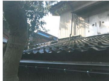
修理後(土蔵戸前の屋根・雨樋)
