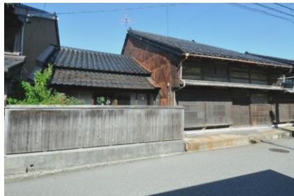
修理前(主屋屋根・壁)
