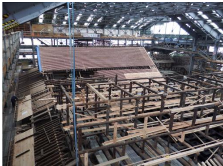
勝興寺 大広間及び式台の修理
