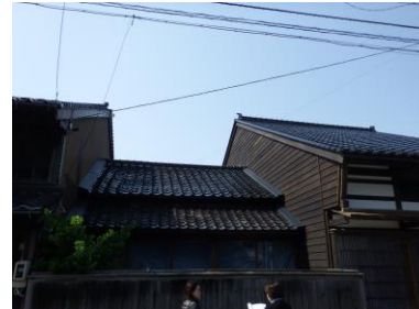
修理後(主屋屋根・壁)
