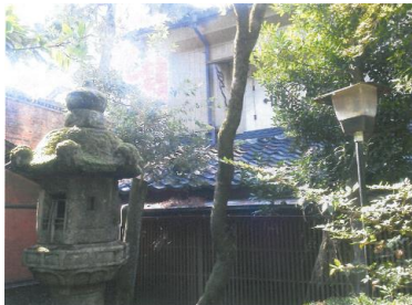
修理前(土蔵戸前の屋根・雨樋)
