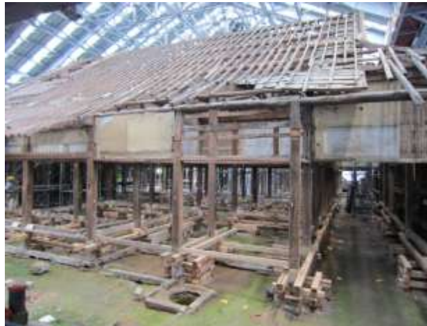
大広間揚屋及び木工事の状況
