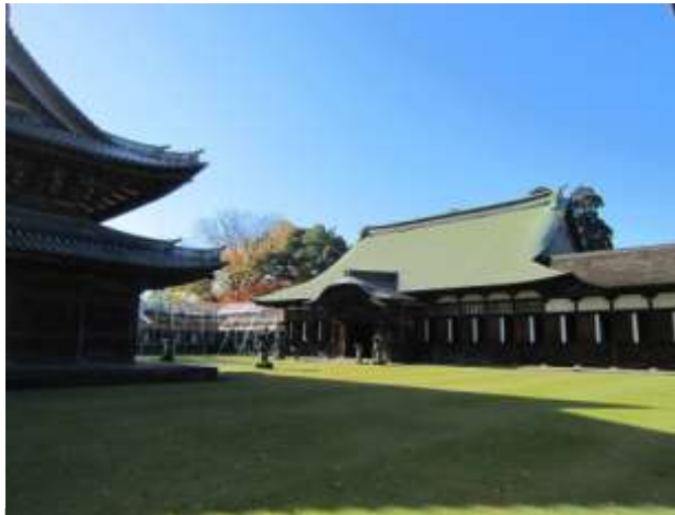
南回廊仮設組立ての状況
