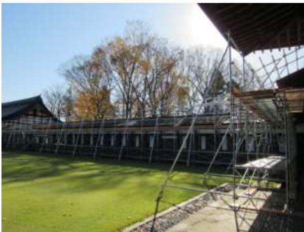
南回廊仮設組立ての状況
