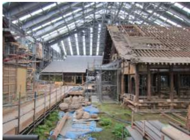
大広間補強鉄骨軸組みの状況(右側) 台所屋根葺きの状況(奥)
