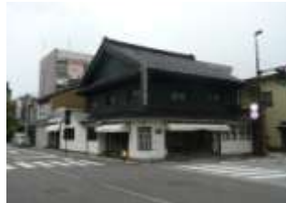
山町筋 主屋修理前
