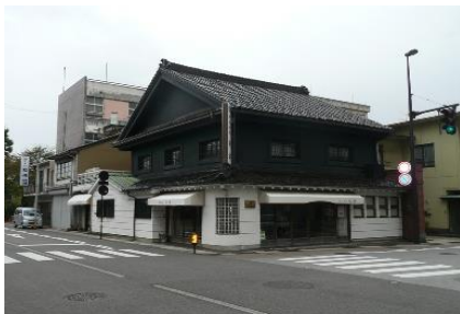
山町筋 主屋修理前
