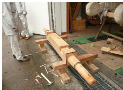
御車山 車軸の修理
