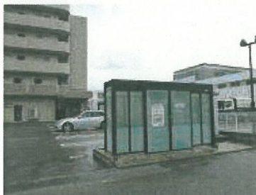
ゴミステーションの修景
