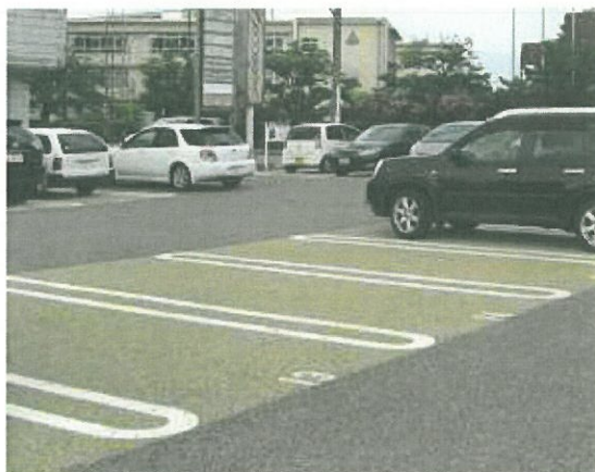
駐車場カラー舗装
