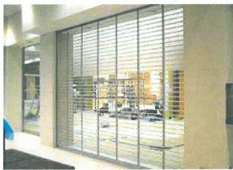
店舗のパイプシャッター
