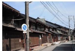
町並み景観を阻害する電線類
