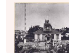
旧伏木測候所
