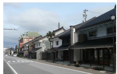
無電柱化された歴史的な町並み
