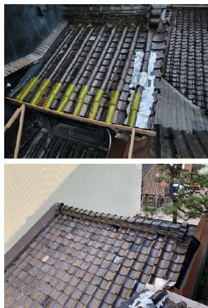
瓦のズレ、破損等の被害
