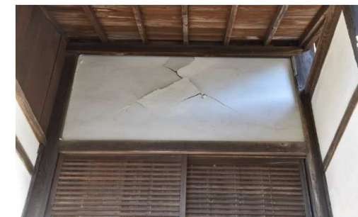
内陣金箔漆塗柱の亀裂、漆喰壁割れ等の被害
