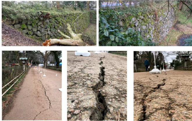
本丸土橋の地割れ、石垣の歪み等の被害
