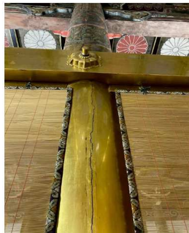
内陣金箔漆塗柱の亀裂、漆喰壁割れ等の被害
