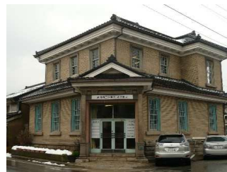
高岡商工会議所伏木支所 (旧伏木銀行)
