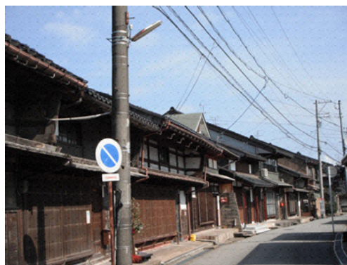
町並み景観を阻害する電線類
