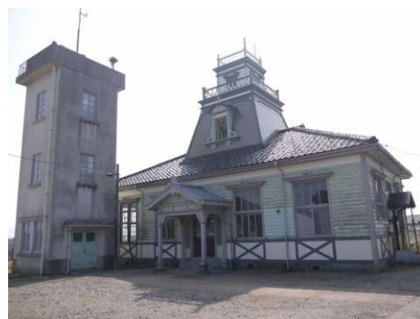
旧伏木測候所
