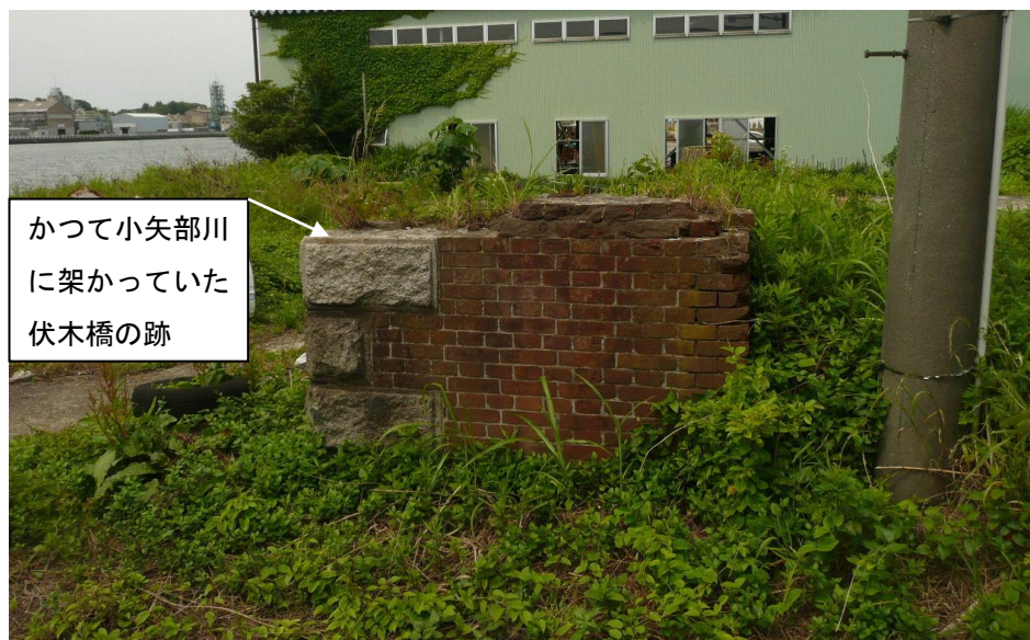
伏木橋の跡（吉久）
