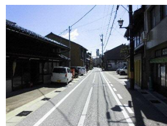
道路修景整備事業 （山町・金屋町道路整備事業）
