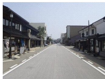
山町筋無電柱化事業 H23
