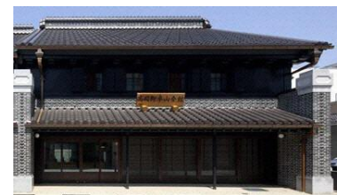
高岡御車山会館建設事業 H27.4
