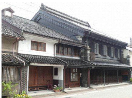
山町筋の町並み（木舟町）
