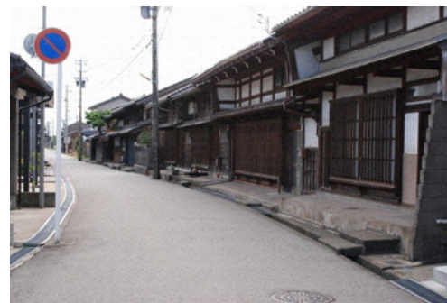
吉久の町並み（北東から）
