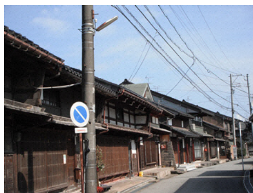
町並み景観を阻害する電線類
