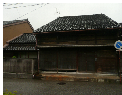
丸谷家住宅（旧津野家住宅）主屋
