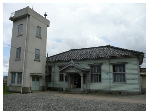
伏木測候所庁舎・測風塔
