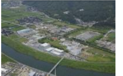
■ 高岡北インターチェンジ
