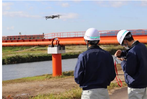
【ドローンを用いた施設点検】
