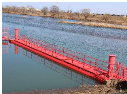
【取水口防塵フロート塗装修繕工事】
