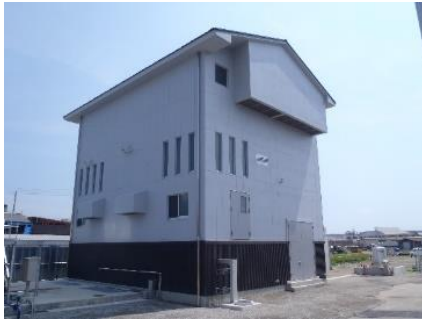
【住吉ポンプ場雨水施設（建屋）】
