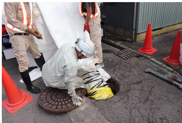
【管更生工事】（更生管材挿入の様子）
