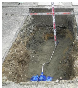
【鉛給水管布設替工事】
