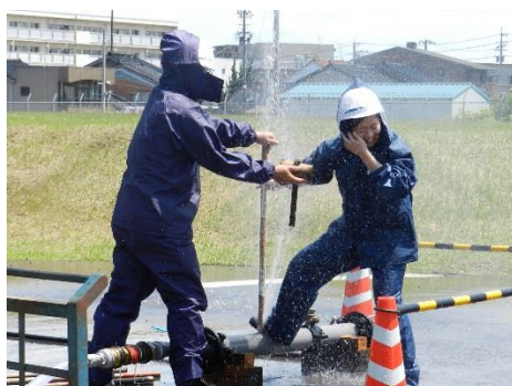
【応急復旧訓練の様子】
