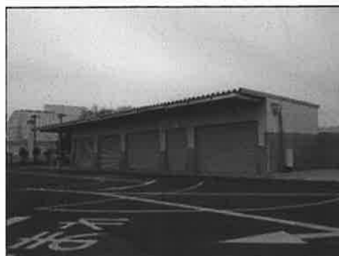
ストックヤード棟 (ごみ保管場所)
