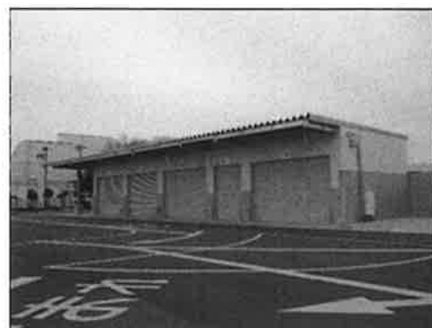
ストックヤード棟（ごみ保管場所）
