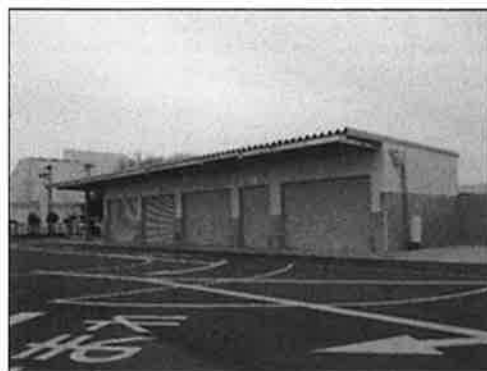
ストックヤード棟（ごみ保管場所）
