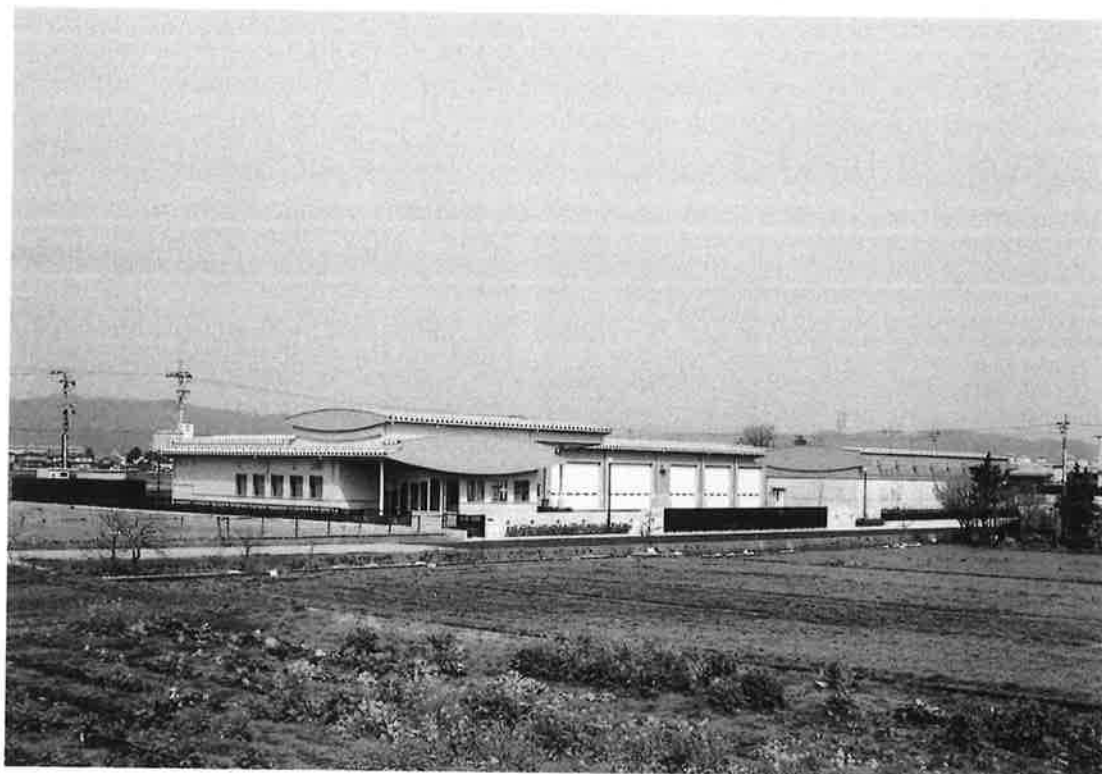
旧福岡リサイクルセンター
