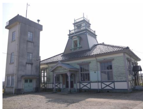
旧伏木測候所
