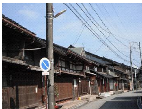
町並み景観を阻害する電線類
