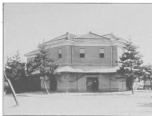
高岡米穀取引所（『富山県写真帖』 富山県編（明治42年（1909））より）
