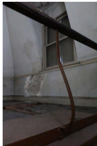
北棟3階塔屋部 残る当初手摺子の一部
