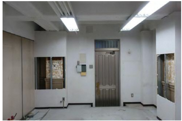
南棟旧重役室（S1-3）の隠蔽された当初壁面
