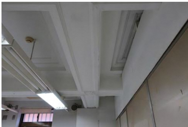
南棟旧重役室（S1-3）に残る当初天井
