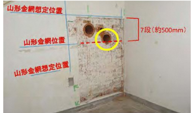
コア抜き位置（北棟1階階段室） （清水建設・日本診断設計・ジャスト）
