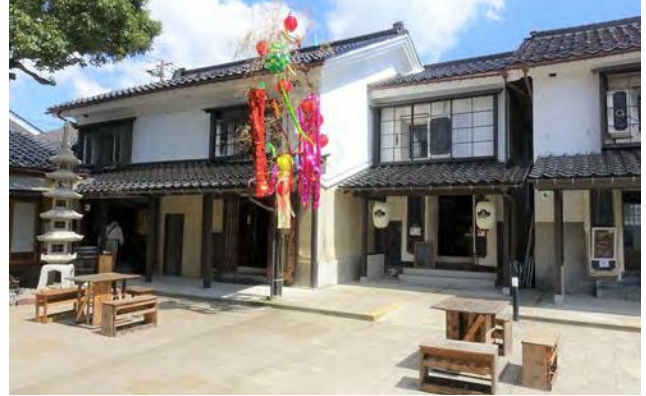
写真 1-02 山町ヴァレー (山町筋伝統的建造物群保存地区)
