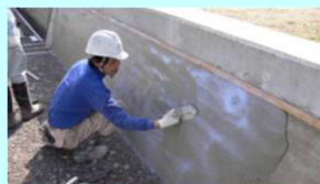
老朽化した水路壁のコーティング
