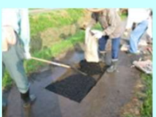
農道の部分補修
