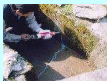
水路のひび割れ補修
