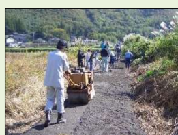
未舗装農道の舗装
