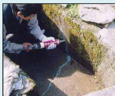
ひび割れの補修
