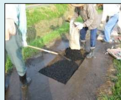
農道の部分補修
