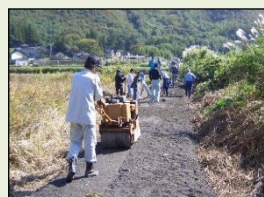
未舗装農道の舗装
