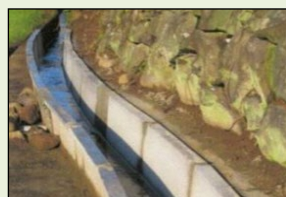
素堀り水路からの更新
