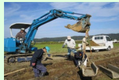
コンクリート水路の更新
