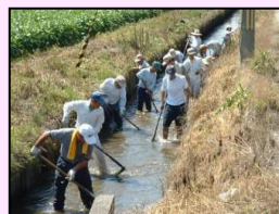
水路の泥上げ
