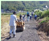
未舗装農道の舗装
