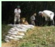
漏水箇所 の 補修
