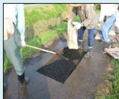
農道の部分補修
