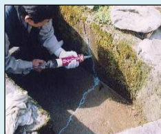
ひび割れの補修
