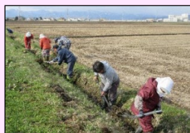
水路の泥上げ
