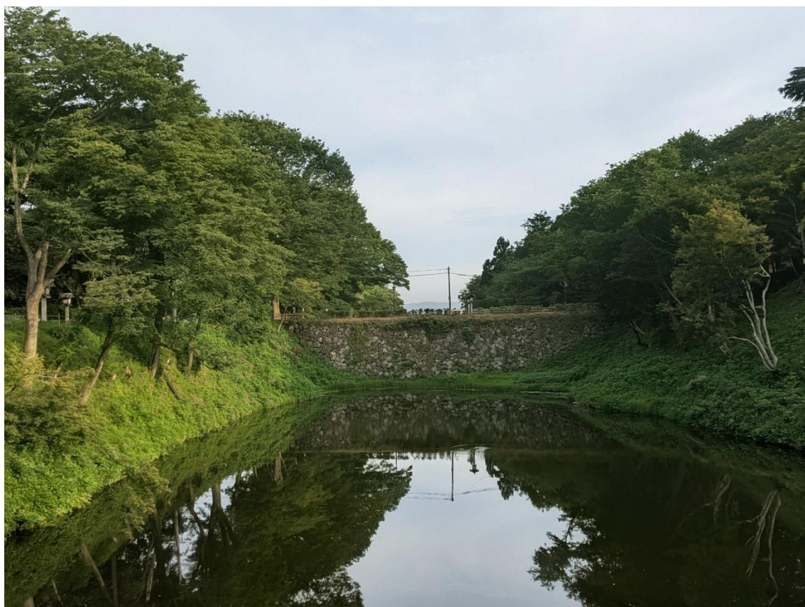
高岡古城公園（本丸土橋の石垣）
