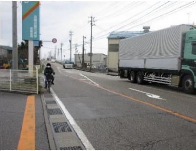
⑭ (都) 戸出東西中央線（二期区間） （戸出町二丁目～戸出町一丁目）
