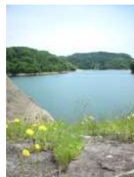
3,000haの下流域の農地へ農業用水を供給する五位ダム
