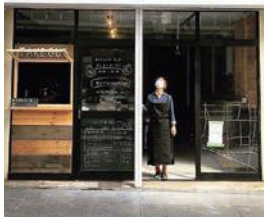
商店街の空きビルのリノベーション事例
