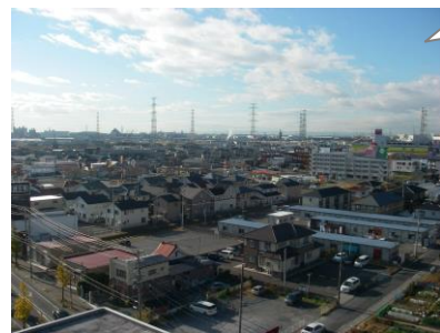
津波で浸水したビルより仙台港を望む
