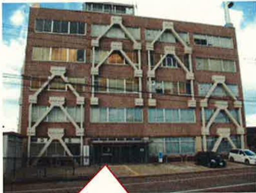
伏木港湾合同庁舎は、正面入口から入り2階から5階の廊下が避難スペースです。
