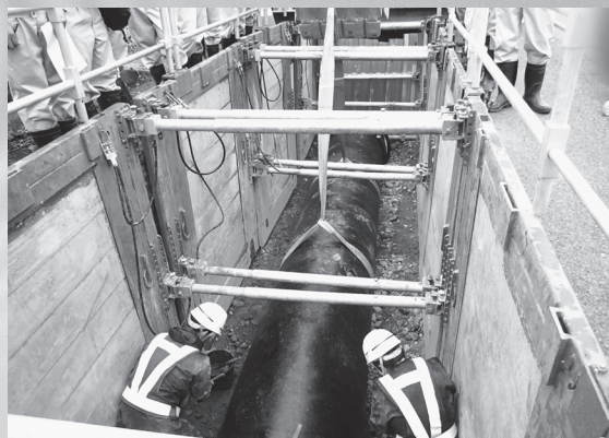
▲水道管路の耐震化の様子
