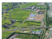
高岡砺波スマートインターチェンジ
