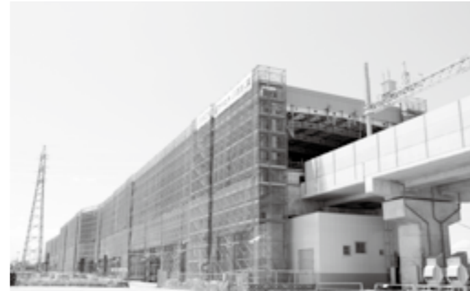
新高岡駅の工事風景。平成27年春に開通します
