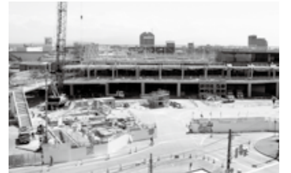
高岡駅の工事も進んでいます
