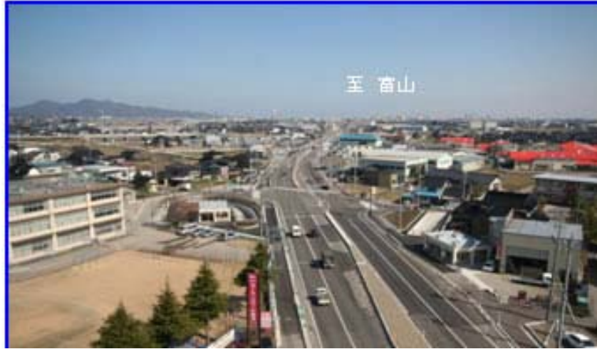
国道 8 号西高岡拡幅事業
